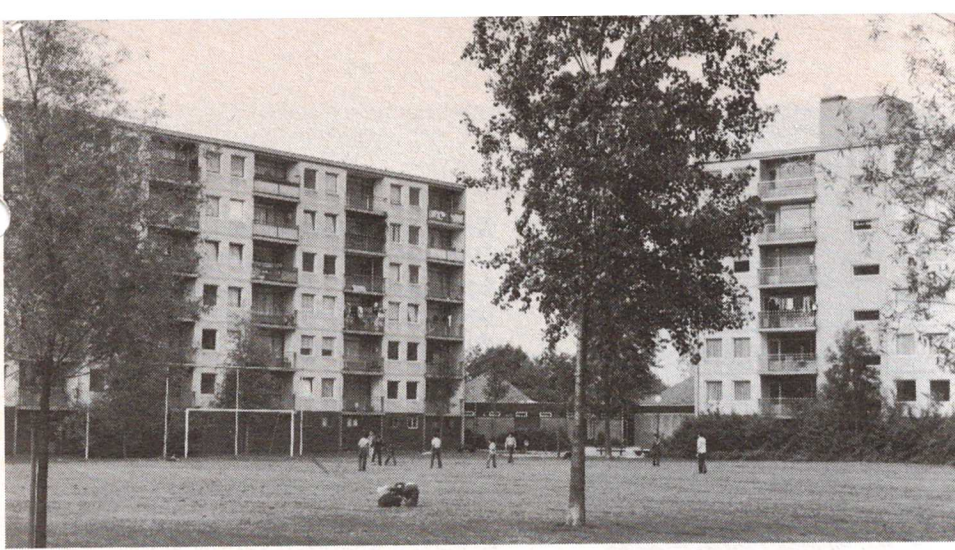
Van het complex Jagershoven in Helmond worden onder andere de bovenste drie lagen geheel of gedeeltelijk gesloopt. Het stedenbouwkundig plan wordt verdicht door de bouw van eengezinswoningen.
