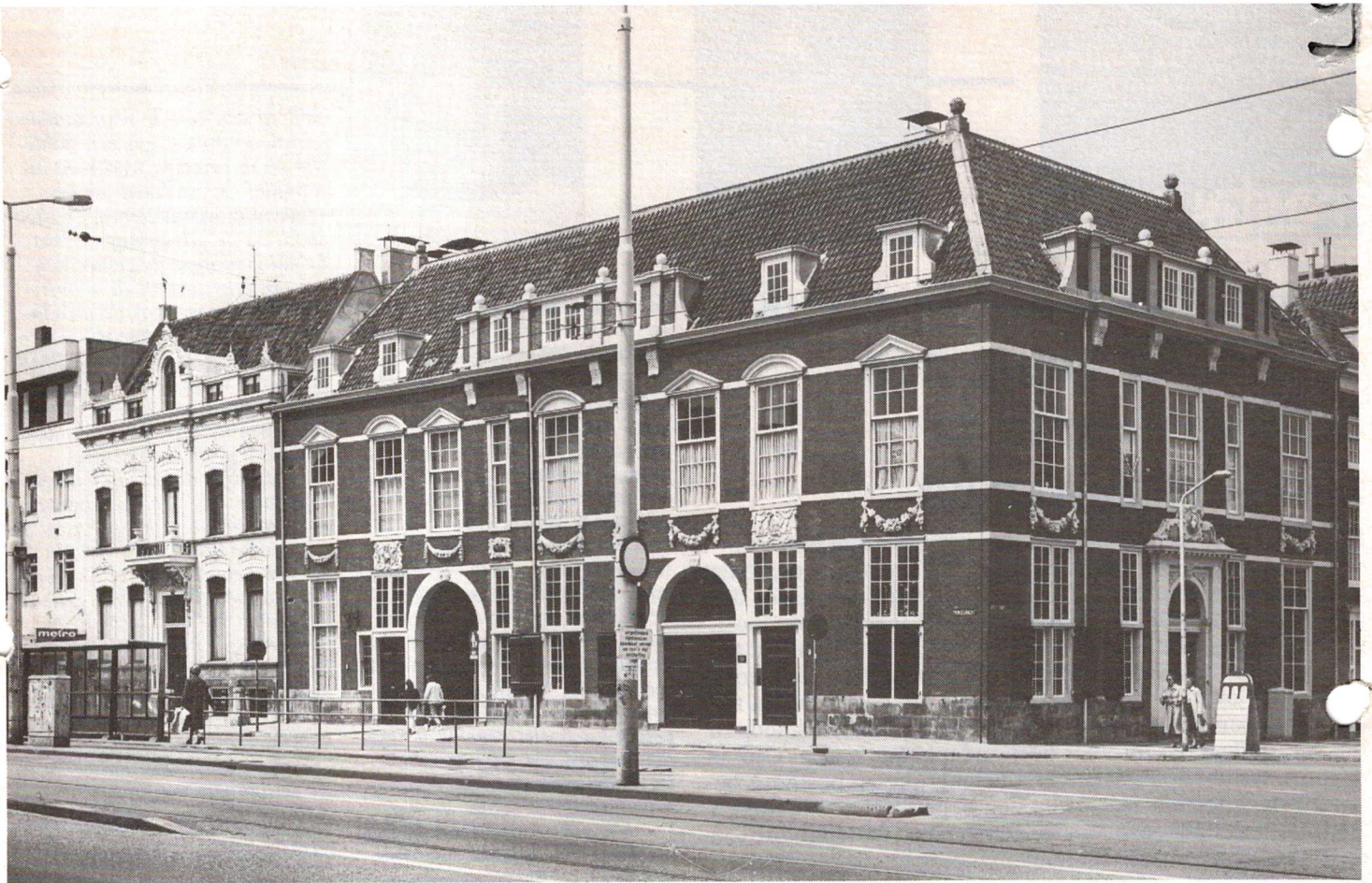
Gemeentelijke woningbedrijven zetten vele nieuwe ontwikkelingen in gang, zoals bijvoorbeeld de verbouw van grote panden tot wooneenheden voor één- en tweepersoons huishoudens. Op de foto het monumentale Boterwaag-complex, waarin totaal 71 wooneenheden zijn opgenomen.
